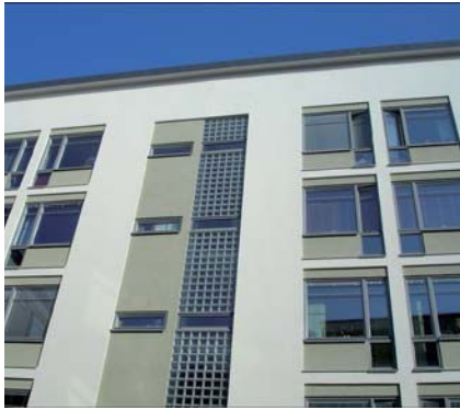
referensbild av putsfält i fasad - Hammarby Sjöstad
