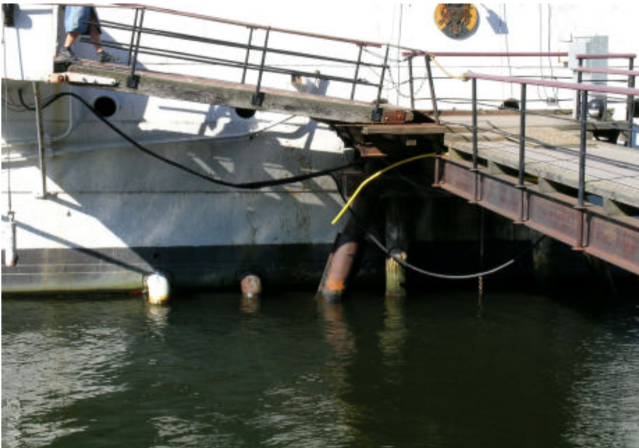
Här visas röranslutningar för avloppet samt pålningen för landgången. Båddera ingår i upprustningsprojektet
