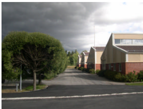
Del av befintlig bebyggelse
