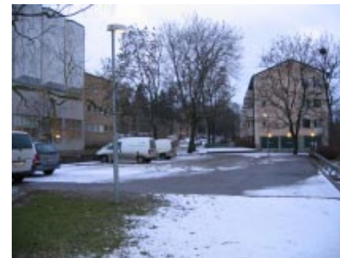
Parkeringen på den aktuella ytan. Byggnaden till vänster är Stockholmshems före detta panncentral
