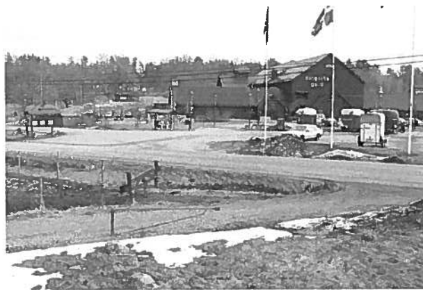
Infarten till Siggesta gård och bussvändslinga samt inlastningsväg till herrgården.
