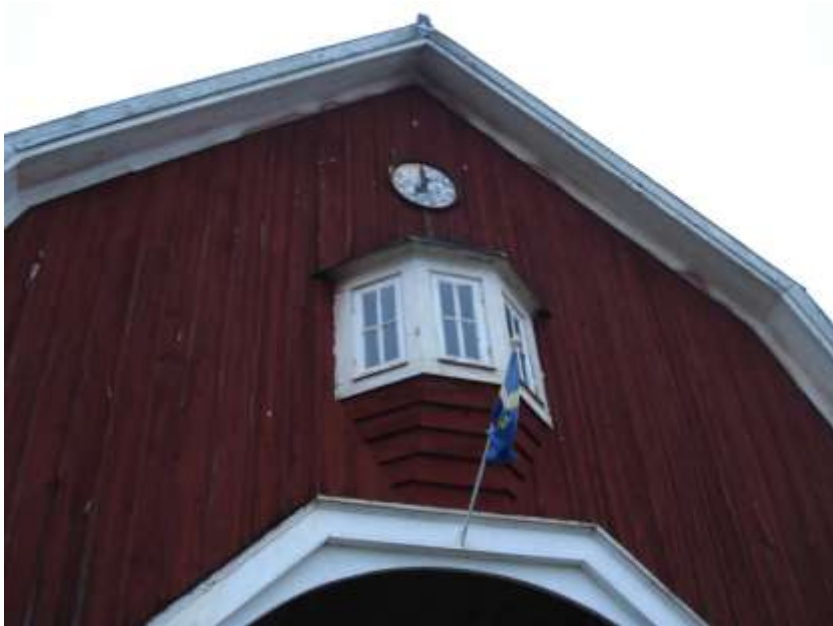
Detalj från vagnslider vid gårdscentrum
