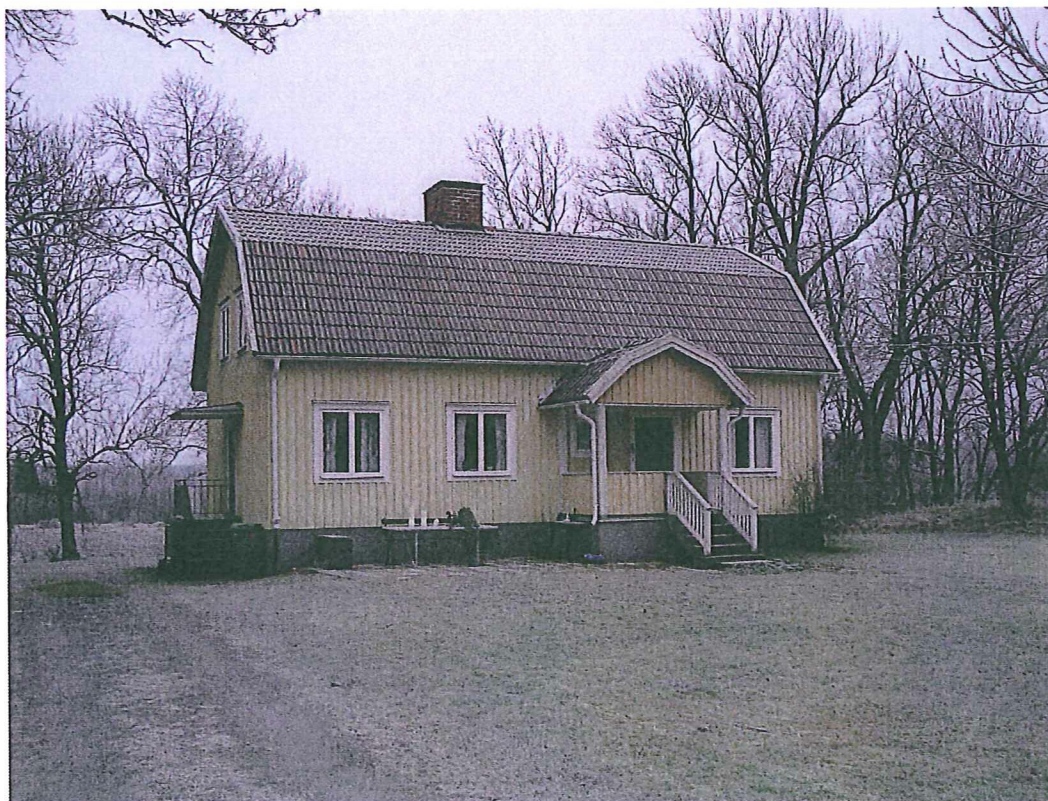
Mangårdsbyggnaden på Lövsättra
