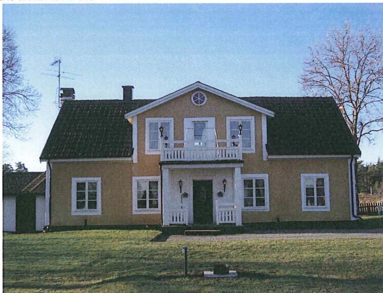
Mangårdsbyggnaden från nordöst
