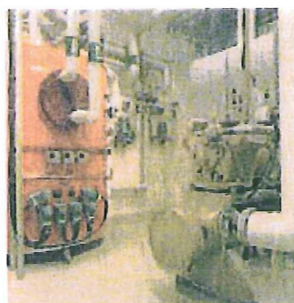
29. Varmvattenberedare och kylkompressor
