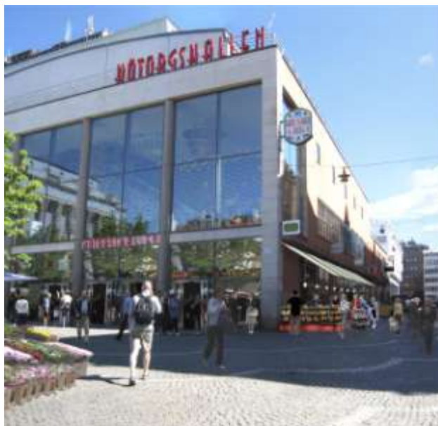
Hötorgshallen med verksamhet lokaliserad utefter Slöjdgatan
