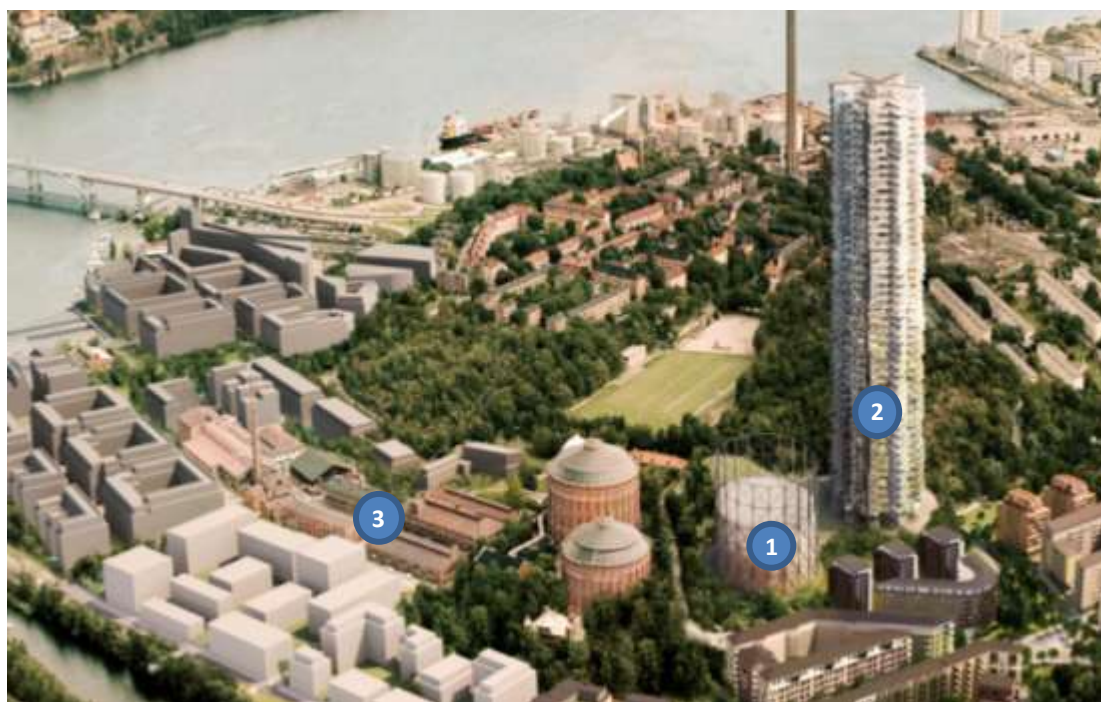
Översikt, Norra Djurgårdsstaden. 1) Gasklocka 3 byggs om till konsthall, 2) Gasklocka 4 rivs och byggs om till bostäder, 3) Gasverksområdet. Bild: Exploateringskontoret
