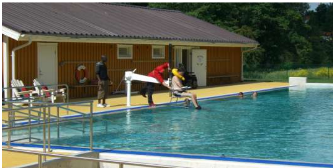
Den upprustade bassängen och intilliggande omklädningsbyggnad
