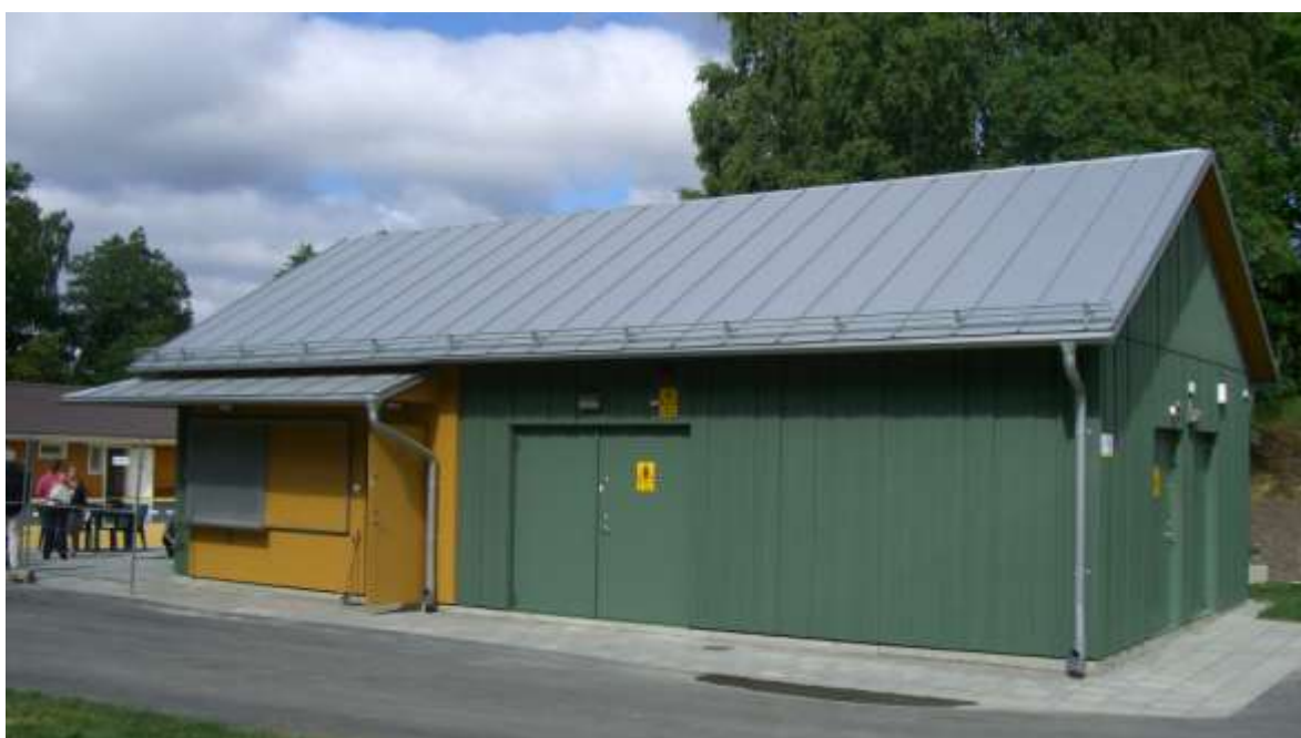
Den nya teknikbyggnaden innehåller bl.a. vattenreningsanläggning och kiosk
