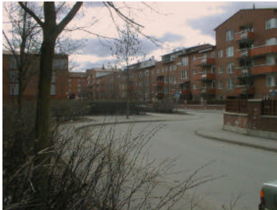
Exempel på en sidoförskjutning vid nybyggnation på Pilvingegatan i Skarpnäck.
