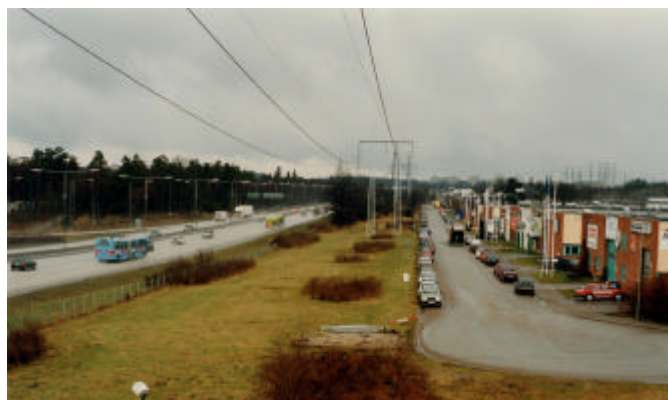
Befintligt grönområde mellan Murmästarvägen och E4/E20, sett söderut från Bredängsvägens viadukt. Det är i denna zon som Nya Skärholmsvägen är tänkt att förläggas i alternativ XL, samtidigt som kraftledningen flyttas åt vänster till den smala kvarvarande grönremsan närmast E4/E20
