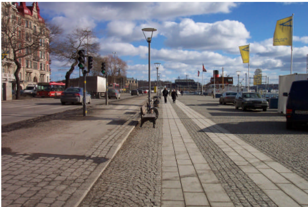
Del av nyrustad kaj. Cykelbana, möbleringszon och gånghällar bildar ett vackert och tydligt golv på kajstråket
