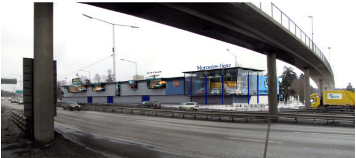
Bilanläggning sett från väster
