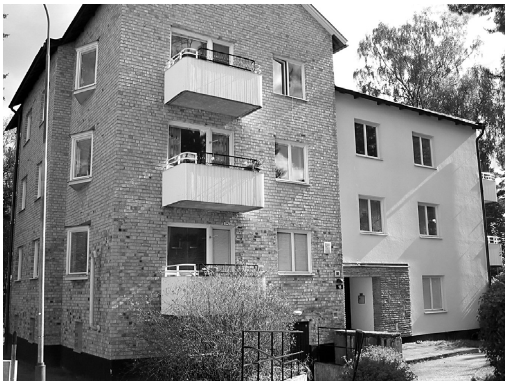
Exempel på punkthus med fasader uppdelade i olika fasadmaterial (kv. Stöthyveln 2)
