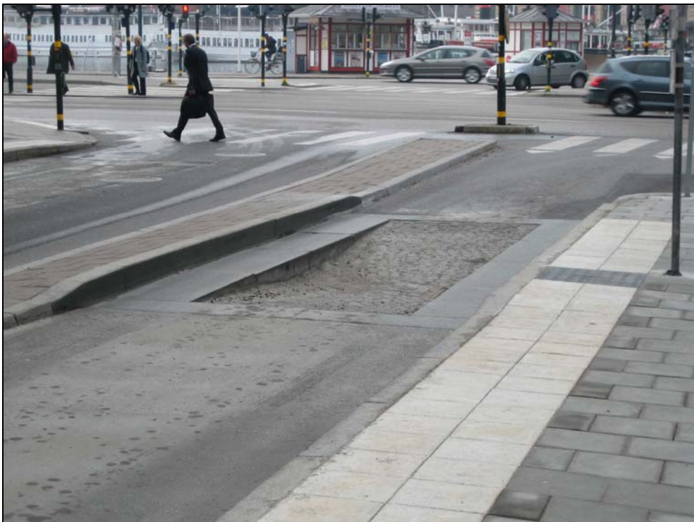
Spårviddshinder på Sibyllegatan vid Strandvägen
