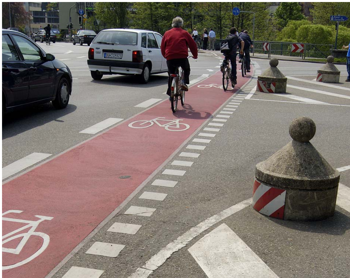
Färgad beläggning i korsning, Freiburg (Tyskland)
