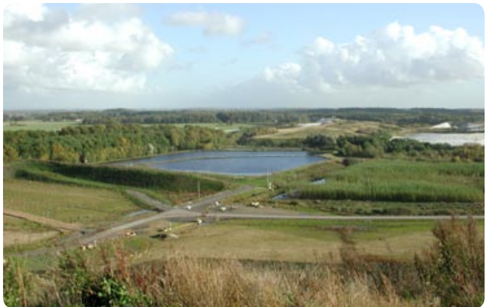
Lakvattenhantering vid en deponi.
