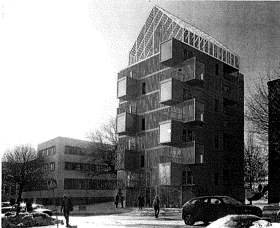
Vy mot Drottning Kristinas väg, söderut.
