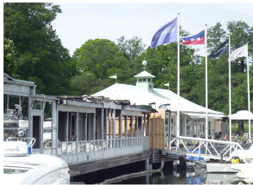
Befintlig byggnad mot småbåtshamnen
