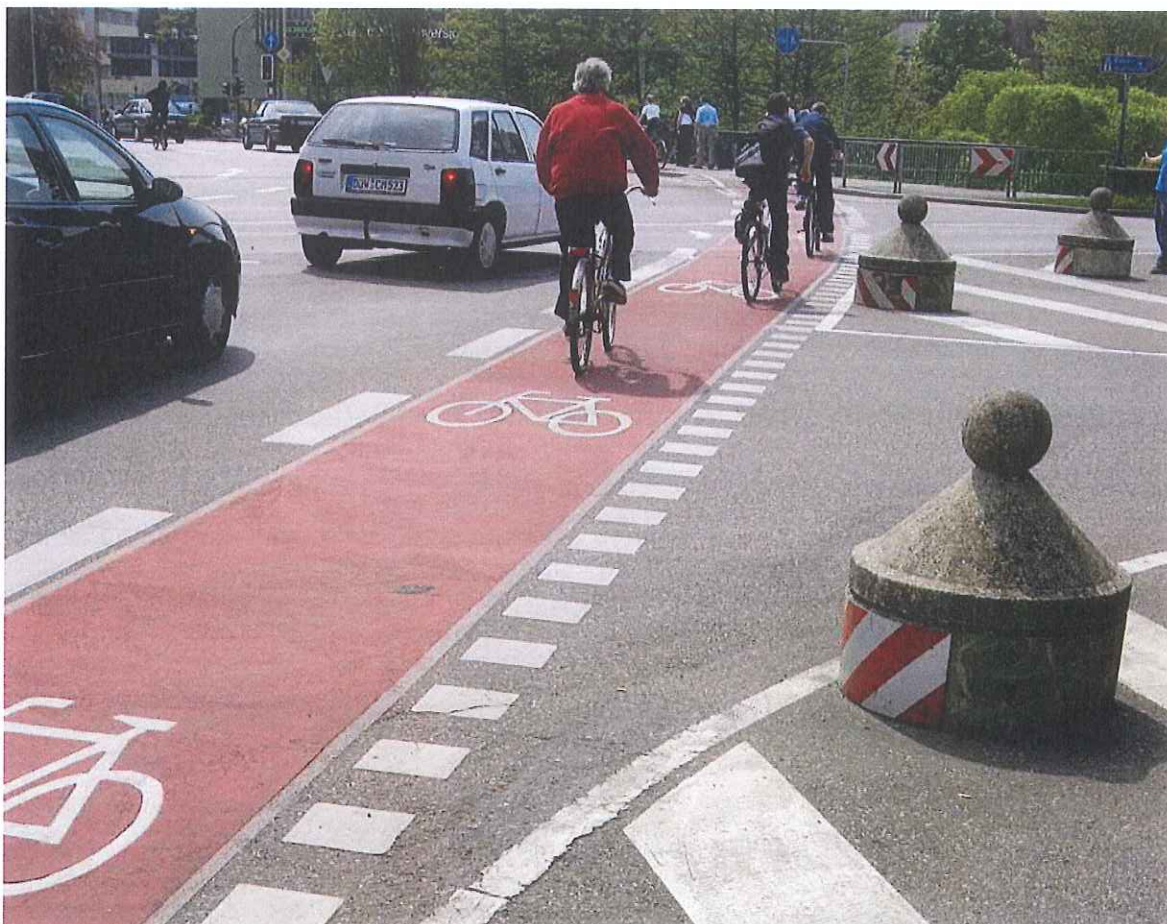
Färgad beläggning i korsning, Freiburg (Tyskland)
