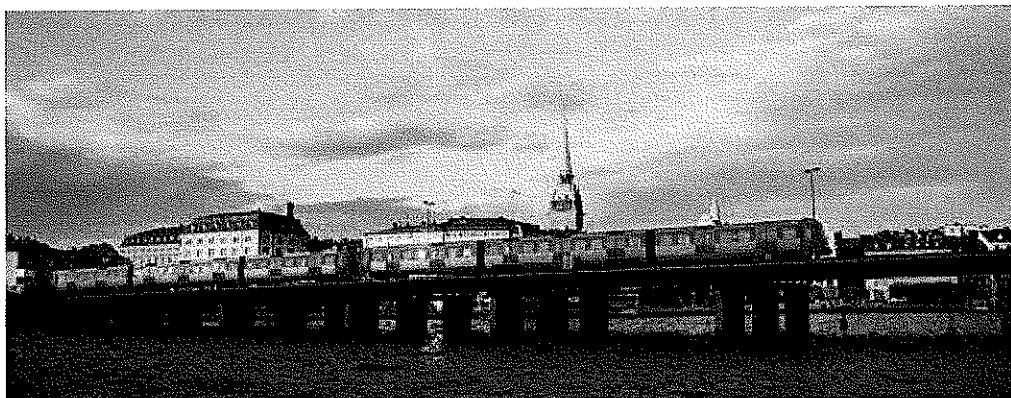
Figur 24 Tunnelbana mellan Slussen och Gamla stan, www.sl.se
