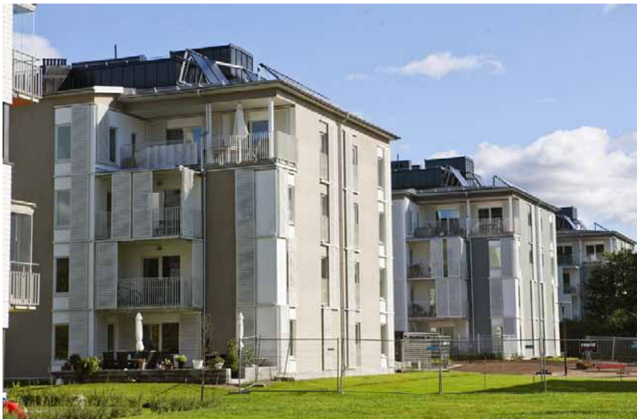
Lågenergihus i Beckomberga med solfångare på taket
