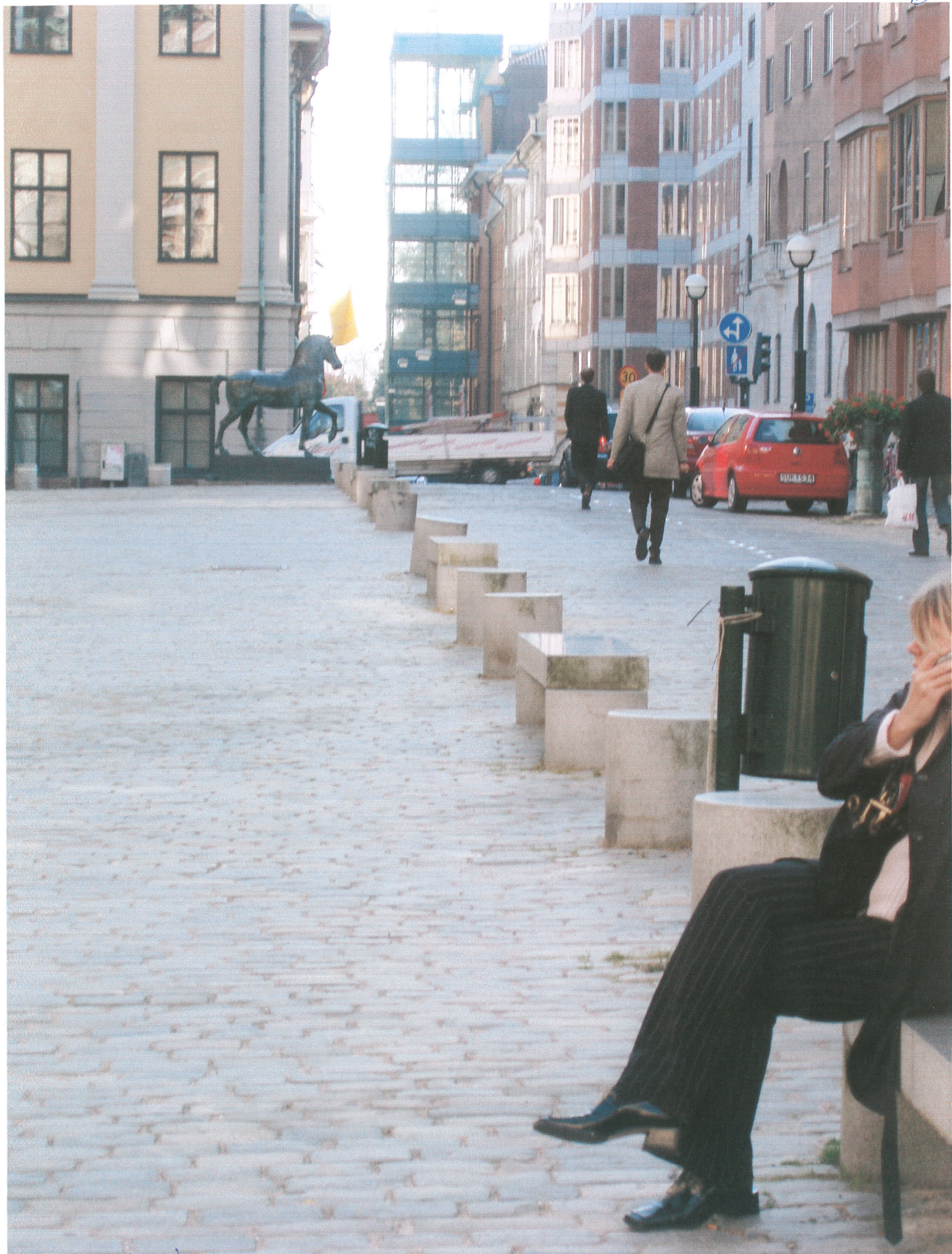
Blasieholmstorget 2005-10-14 De flesta stensömlarna är påkörda och lutar åt olika håll
