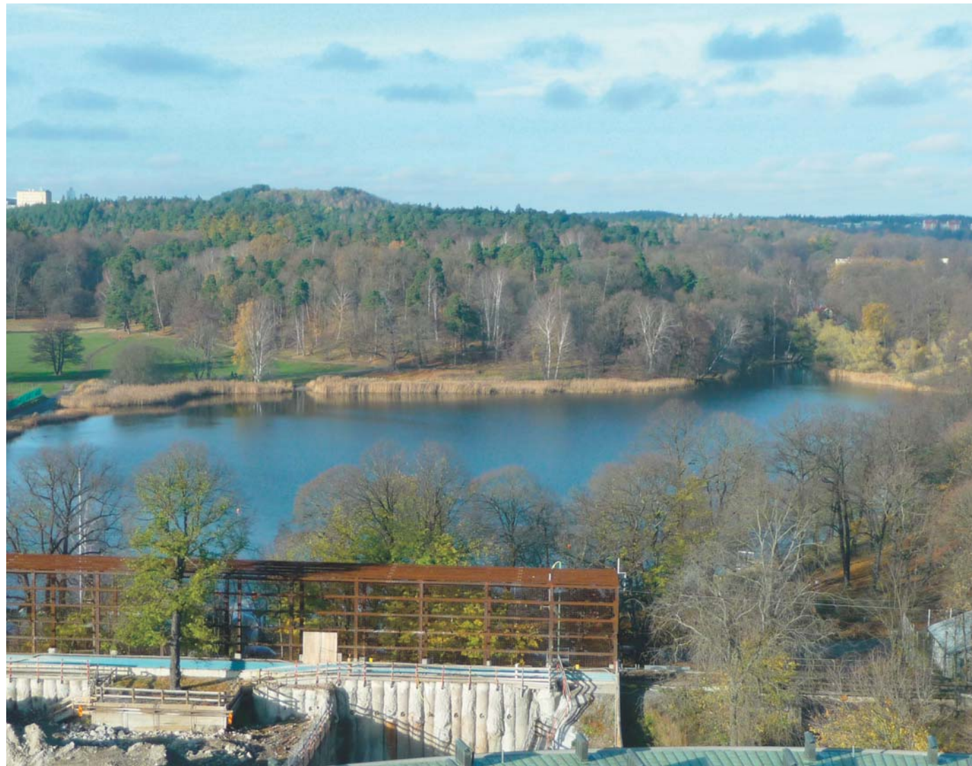
I väst och nordväst angränsar Bellevueparken till Hagaparken. Från parken ges storslagna utblickar över vattnet och omgivande höjder. I bildens nedkant ses pågående arbeten för Norra länken.
