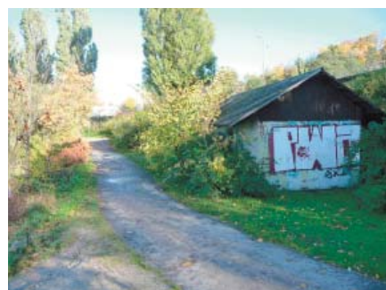
Ett pumphus som inte är i bruk skymmer kontakten med Brunnsviken i parkens nordöstra del.
