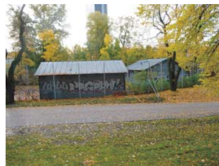
En inhägnad och bodar för det parklag som arbetat i parken förfular och skymmer utblickar och hindrar framkomlighet.
