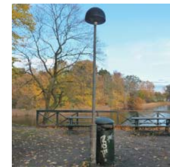
Befintlig belysning på Stallmästarholmen utgörs av stolpar från 1950-talet och armaturer från 1980-talet.
