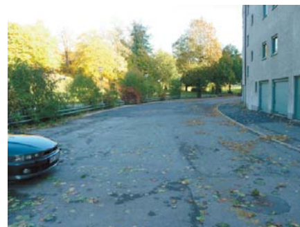
Stora parkeringsytor i asfalt längs Wenner-Gren Center är ett tråkigt blickfång från parken.
