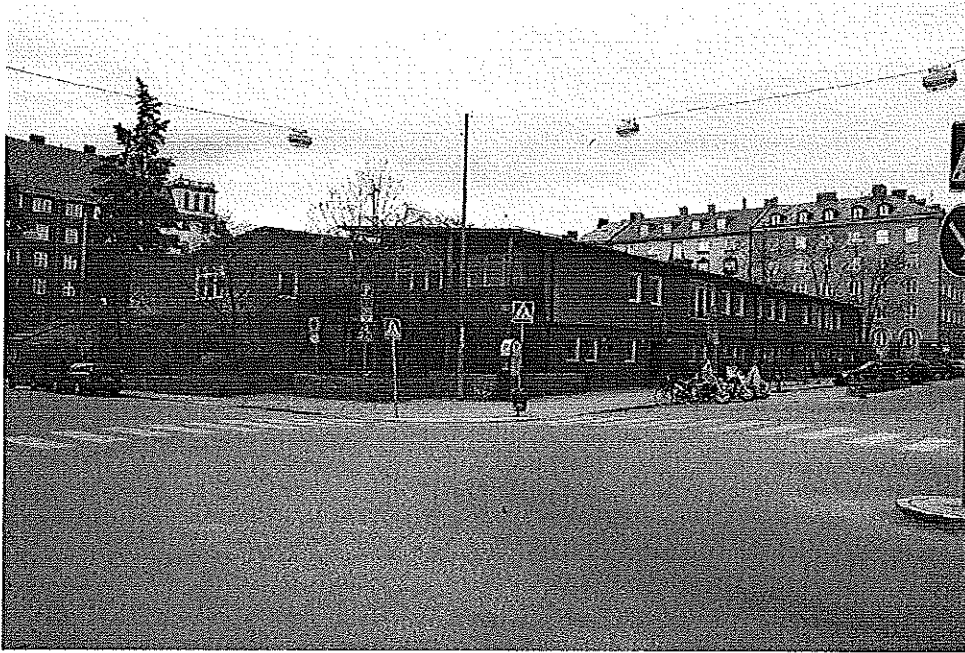
Montessoriskolans byggnad som den ser ut idag
