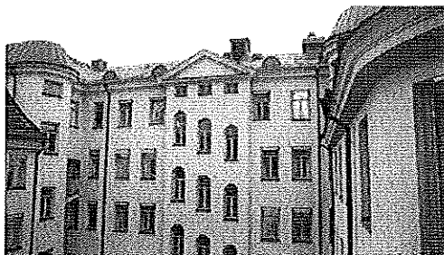
Östra gårdsfasaden mot Malmtorgsgatan
