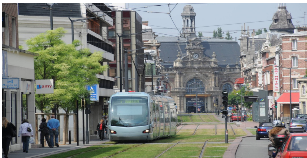
Figur 10 Fransk spårvagn på egen bana, skild från både bil- och busstrafik, vilket även möjliggör gräsbeklädda spår. Foto: PG Andersson
