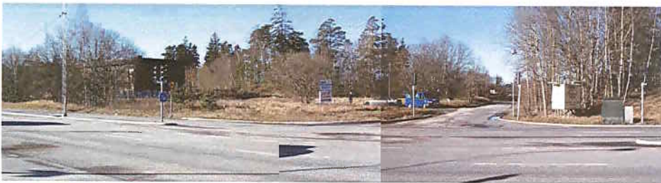
Anonym entré till området för biltrafik, en kraftnätstation dominerar intrycket.
