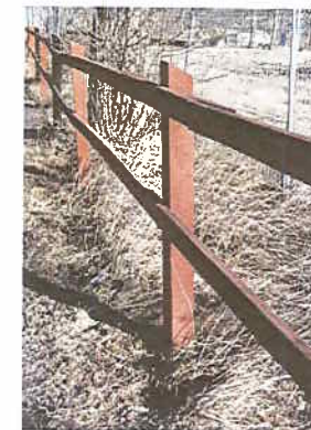
Befintligt trästaket i området.
