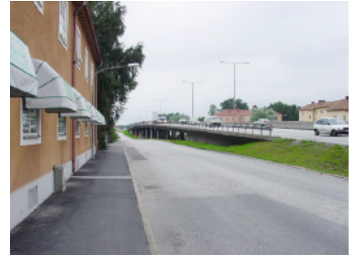
Viadukten över Sockenvägen
