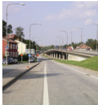
Delområde 3, Viadukt över Sockenvägen
