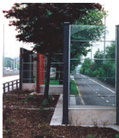
Tvärställda glaspartier ger genomsiktighet i träplank. Exempel från Göteborg
