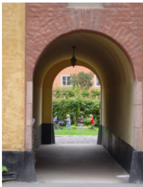
Lummiga gårdar bullerstörs p.g.a. öppningar mot Nynäsvägen.
