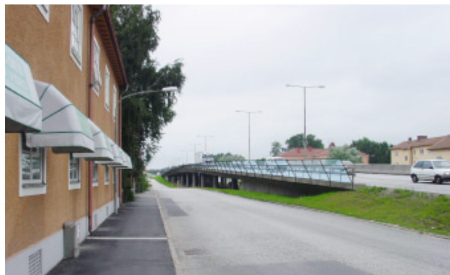
Förslag, med glasskärm av typ III på viadukten. Pga trafiksäkerhetskrav och siktförhållanden monteras ingen skärm vid påfartsrampen.
