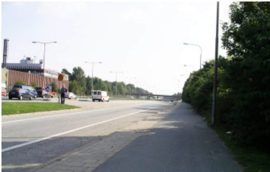
Befintlig bullervall dold i vegetation till höger
