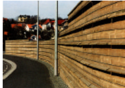
Träplank med utformning anpassad för trafikled, exempel från Göteborg
