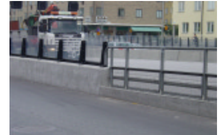
Nuvarande möte mellan den låga befintliga glasbullerskärmen och ett räcke, monterade på betongsocklar.
