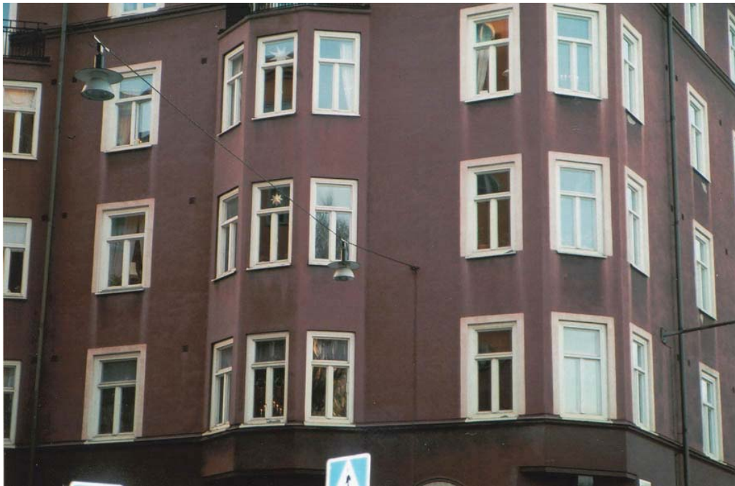
Figur 15. Exempel på att det med gott resultat går att byta fönster i äldre bostadshus utan att påverka utseendet.
