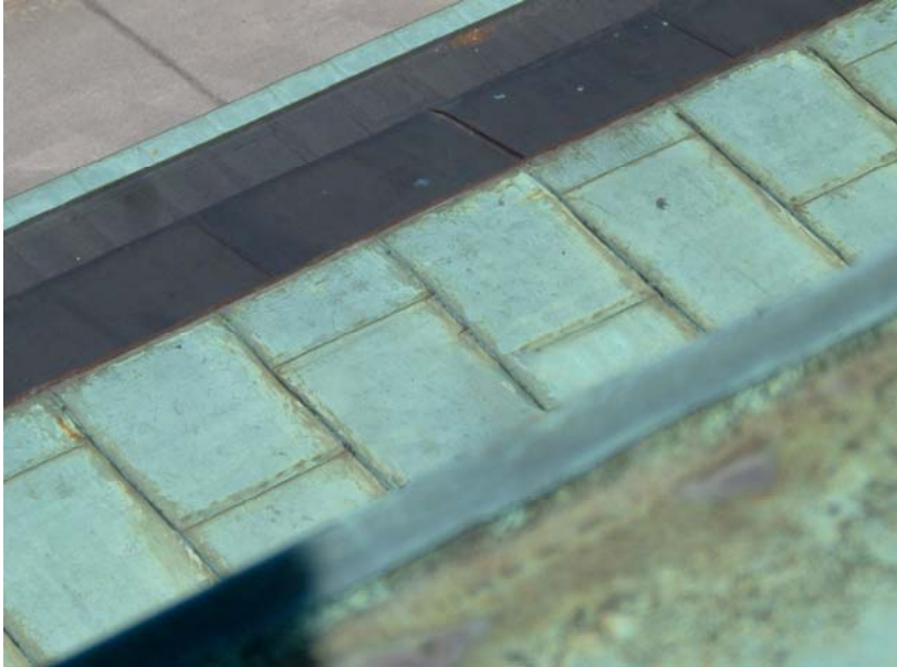
Ökad nederbörd leder till en ökad avrinning av koppar från Stockholms koppertak
