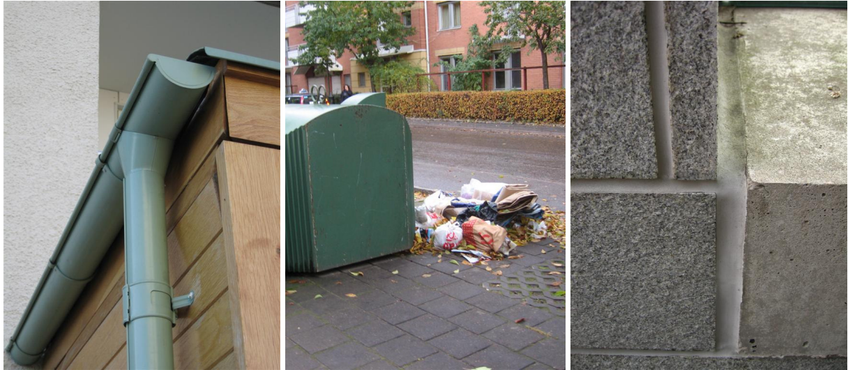
Figur 10. Kartering av källförekomst. Från vänster: belagd plåt för avvattning i Nybohov, "mänsklig aktivitet" i Skarpnäck samt fogmassa i bullermur i Gårda.
