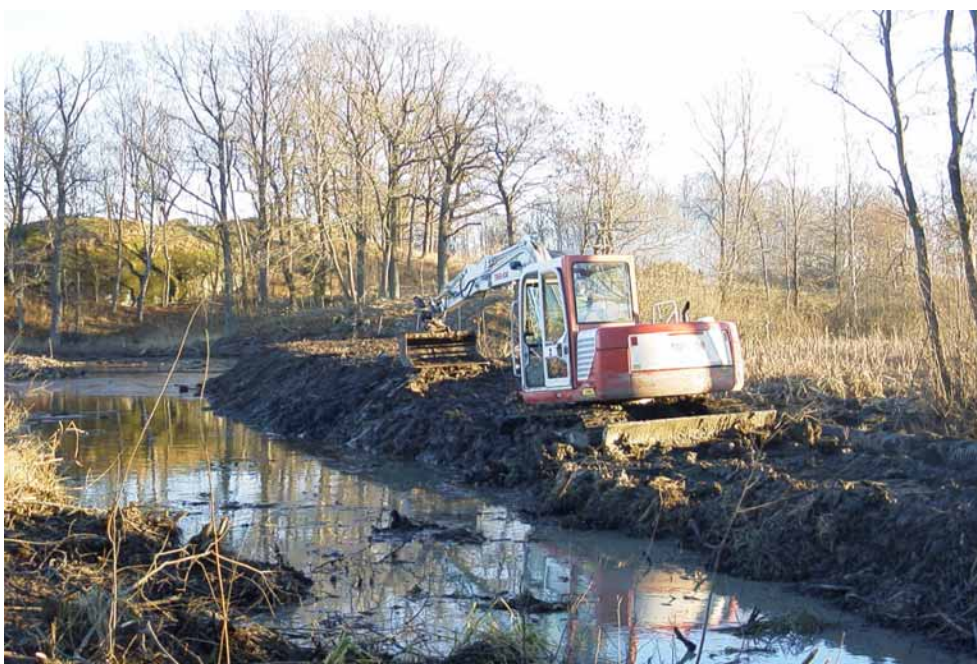
Bild 3: En dammvall byggs vid restaureringen av Balingsta Bottnens våtmark i november 2004. Foto: Thomas Strid.
