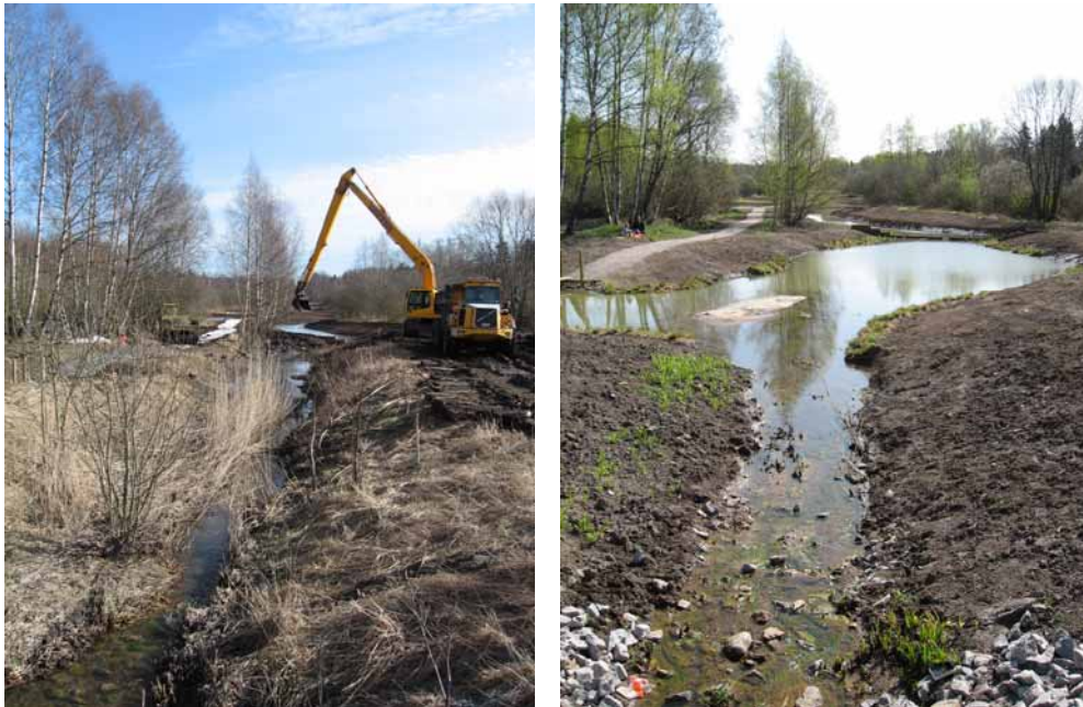
Bild 5. Dagvattenrening i Kräppladiket, i början av byggnationen den 13 mars 2007 och när det är slutfört 27 april 2007. Foto: Klara Tullback Rosenström.
