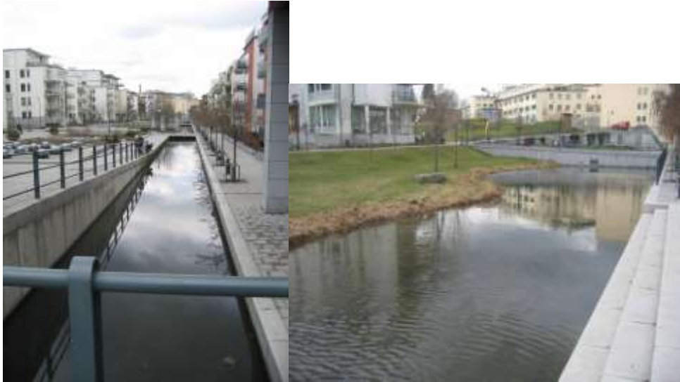
Figur 9: Kanal samt damm för dagvatten från Hammarby Sjöstad.
