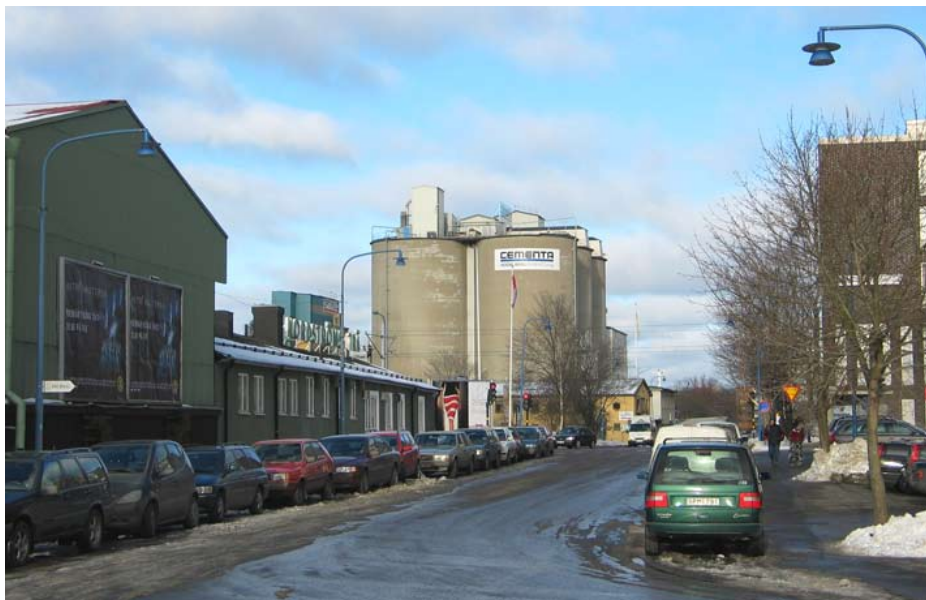
Cementas 30 meter höga silos. I förgrunden ses Nordströms trä.
