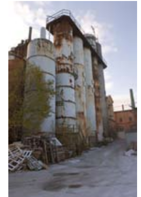
Del av den forna kolsyrefabriken avser Veidekke riva i sin helhet.
