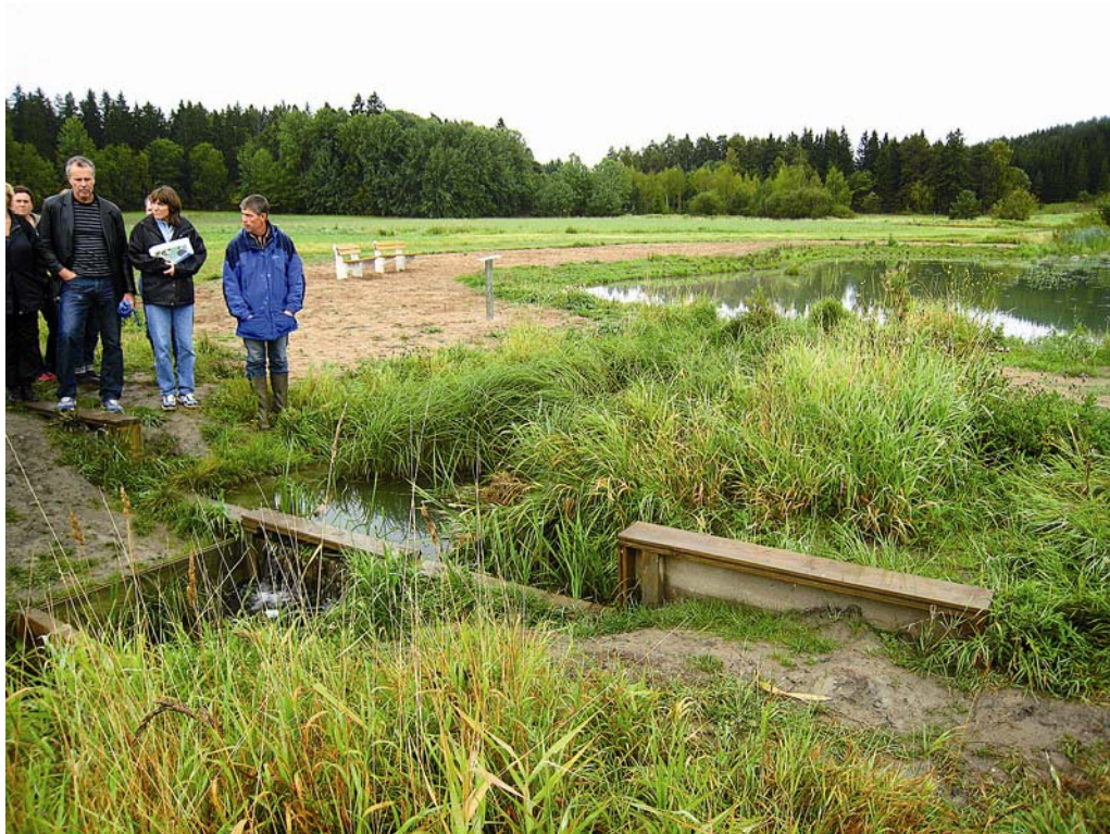
Söder om Hästa gård har en damm anlagts, som är förbunden med Igelbäcken via ett dike. Dammens utlopp är reglerbart för att kunna justera vattennivån. Foto: Magnus Sannebro.
