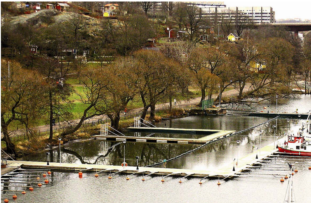
En skärbassäng för rening av dagvattnet från Södra Stationsområdet och Hornstull har anlagts vid Tanto. Foto: Christer Lännergren.
