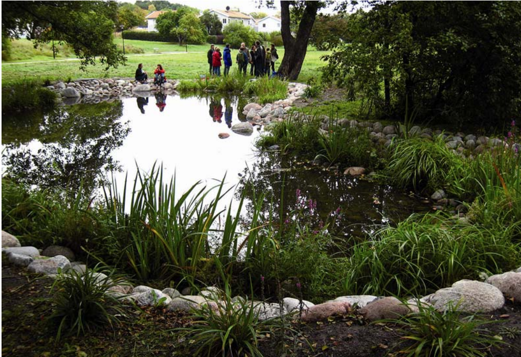
En ny damm har anlagts i Storängsparken, dit dagvatten från Årstafältets dagvattendamm leds. Vattnet fortsätter sedan via Årstabäcken ut i Årstaviken. Foto: Magnus Sannebro.
