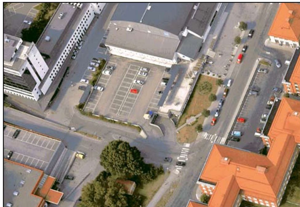
Det nya bostadshuset byggs på befintligt parkeringsdäck
