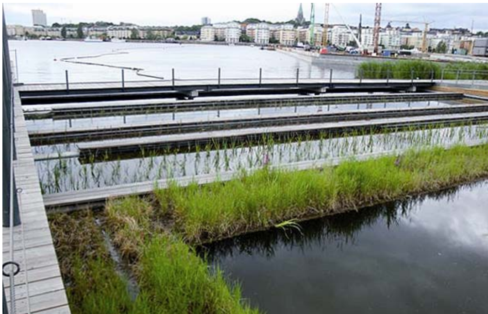
En våtmarksanläggning för rening av trafikdagvatten har anlagts vid Lugnet i Hammarby Sjöstad av Stockholm Vatten. Våtmarken består av damm, flytande växtbädd och översilningsyta med olika växtfack. Foto: Sweco.
