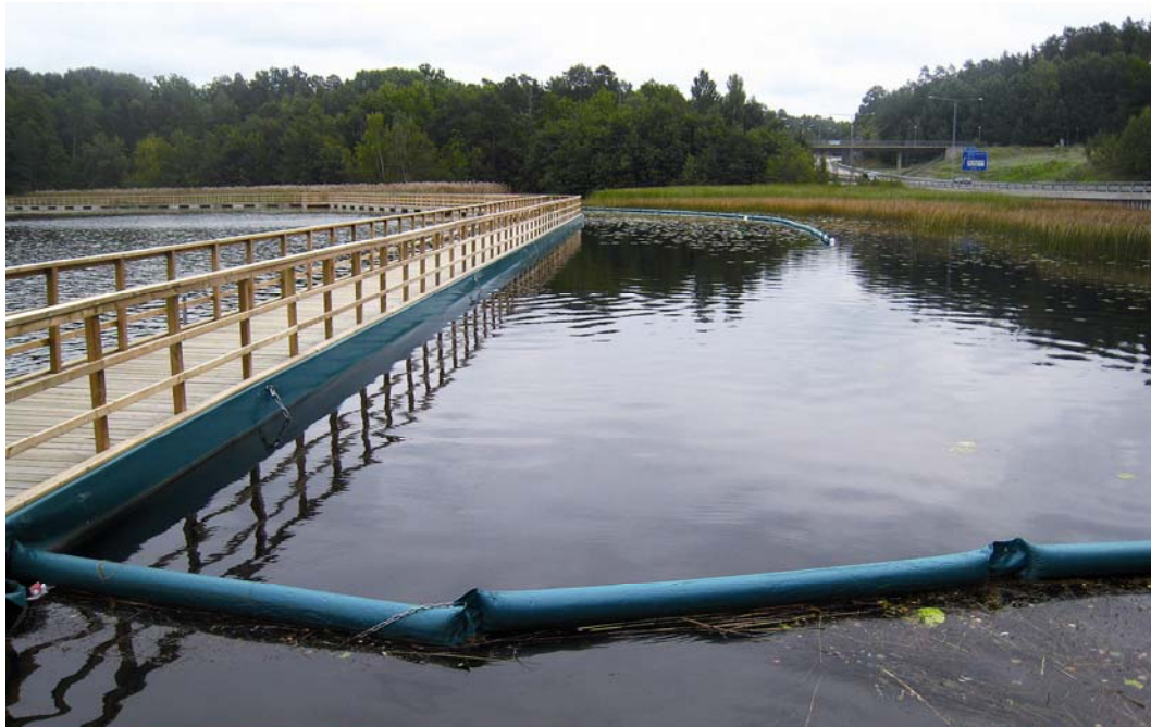
Stockholm Vatten har anlagt en skärmbassäng för rening av trafikdagvatten från Tyresövägen i den inre delen av Kasbyviken, bestående av flytbryggor med nedhängande dukar. Flytbryggorna gynnar även fiske och friluftslivet kring Ältasjön. Foto: Magnus Sannebro.
