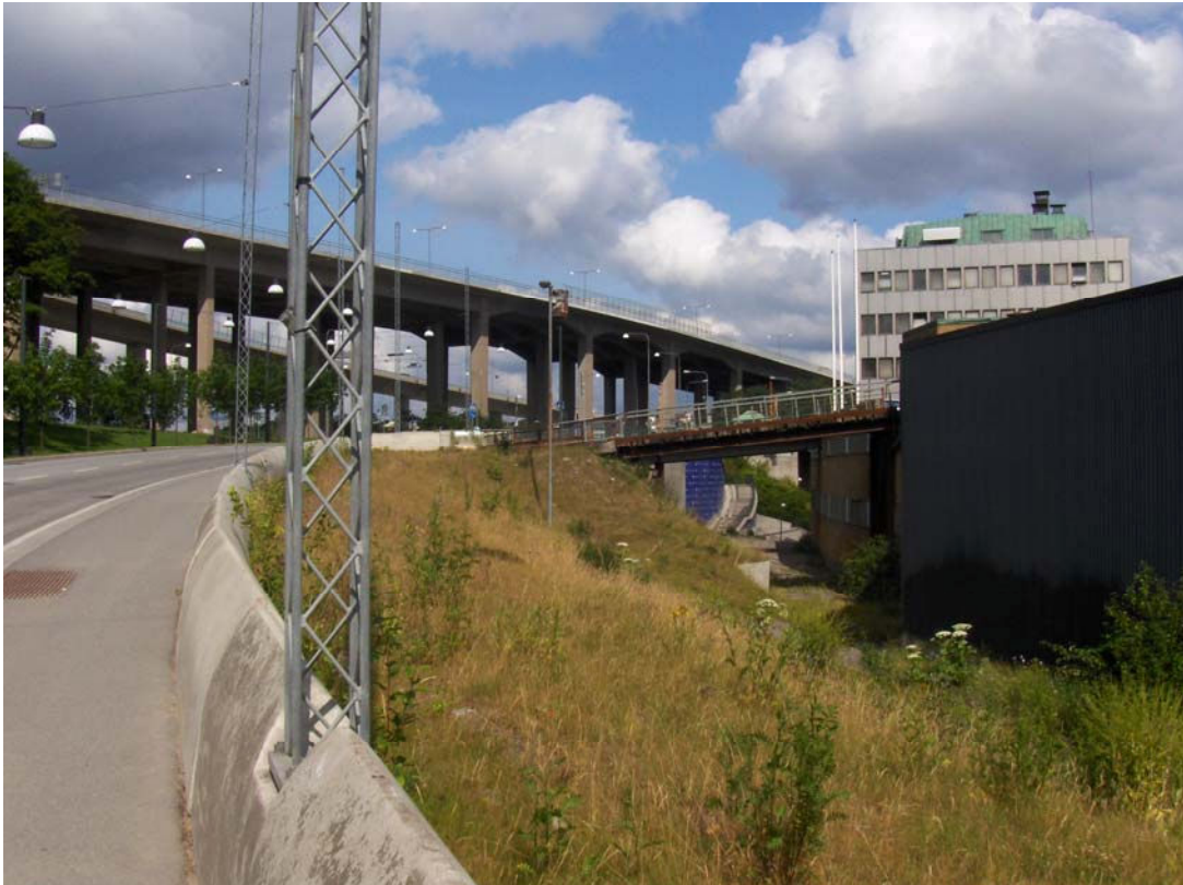
Figur 2.1. Planområdets västra del. I bakgrunden syns Skanstullsbron och bakom den skymtar Johanneshovsbron
