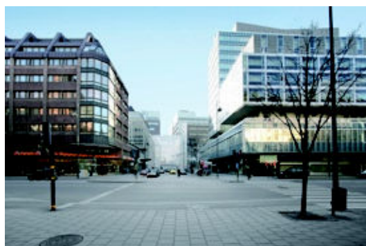
Stationskomplexets entré från Vasaplan
