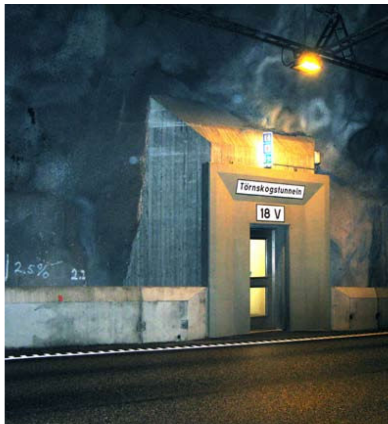
Exempel på nödutgång från Törnskogstunneln
