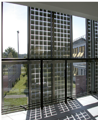
Figur 8: Kiselceller monterade i glas ger ett semitransparent intryck.
