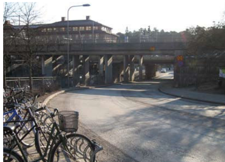
Vidängsvägen söderut ner mot tunnelbanespåren
