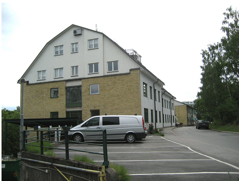
Befintlig byggnad (Sykorgen 7) påbyggd med bostäder
