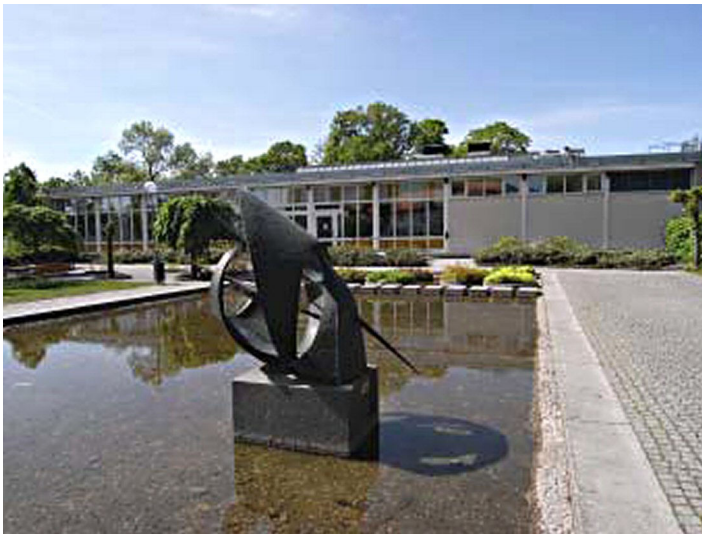
Restaurangbyggnaden vid ”Gunnar Martinssons” park
