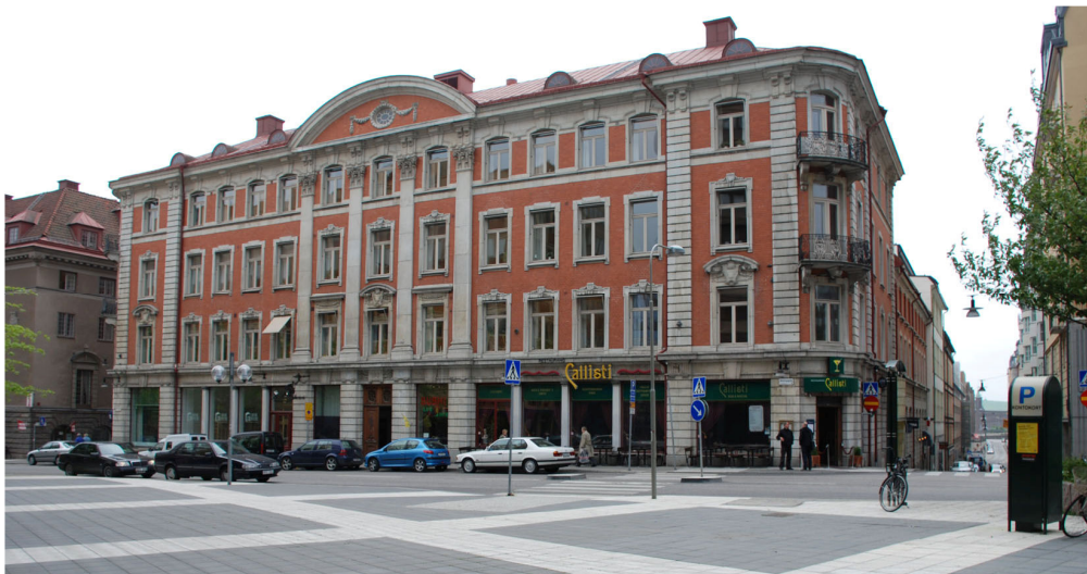
Foto av Brunkhalsen 9 från Brunkebergstorg. (Statens fastighetsverk).
