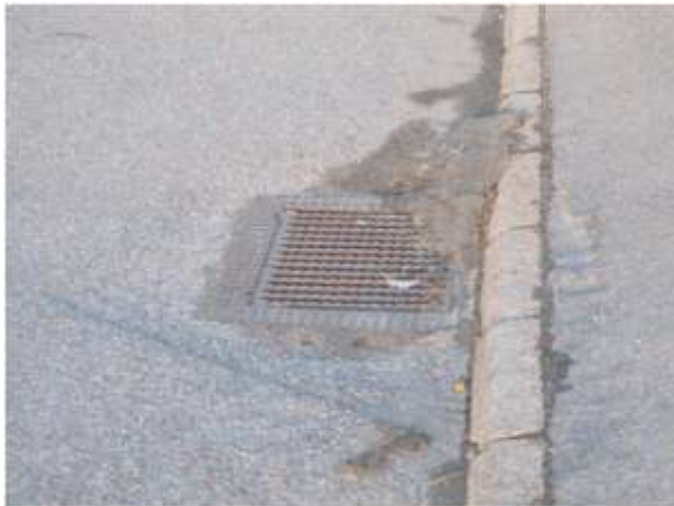
Bild 3 Exempel på en dagvattenbrunn i gatan.
